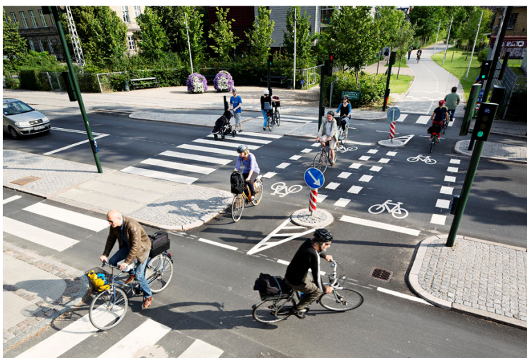
4.13 pav. Geroji praktika: pėsčiųjų perėja su inžineriniais saugumo elementais
