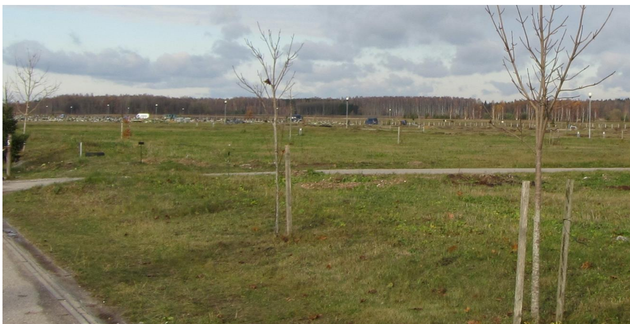
3.2. - 3.3.pav. Lėbartų kapinės.
