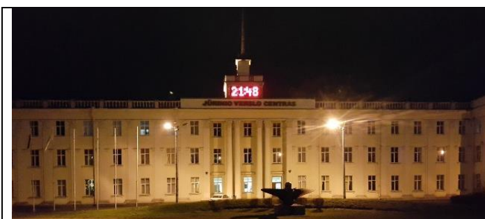
Pav. Nepageidaujamas fasado apšvietimas kai jis apšviečiamas iš šalies plokščiai
