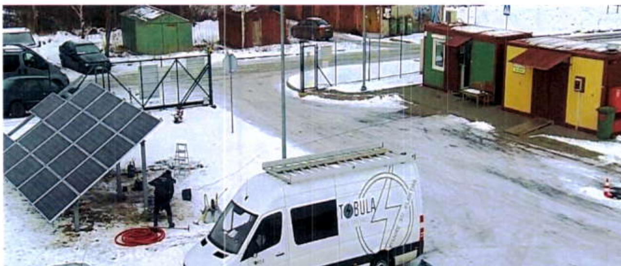
5 pav. Saulės kolektorių įrengimas Šiaurės aikštelėje
