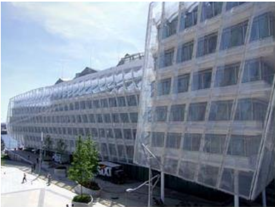
4.5 pav. pastato ir triukšmo užtvaros derinimo pavyzdys- dvigubas fasadas. Sumažina garsą iki 20dB). (Šaltinis –UAB „Estonian, Latvian & Lithuanian Environment” aplinkos triukšmo prevencijos veiksmų organizavimo ir įgyvendinimo pavyzdinis modelis. 2012 m.)
