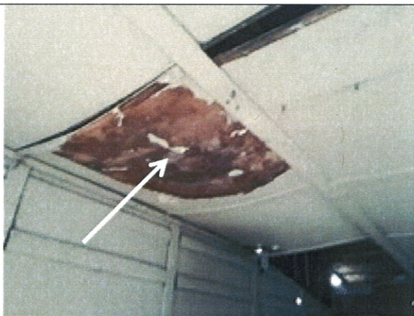
Pav. 7 Vietomis įlinkusios pastato lubos, bet kada gali įlūžti.
