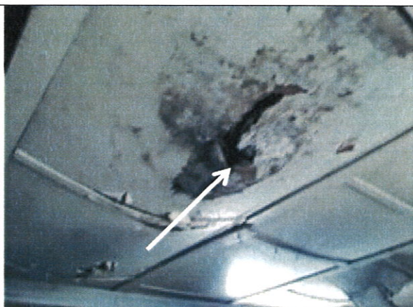
Pav. 6 Vietomis įlinkusios pastato lubos, bet kada gali įlūžti.
