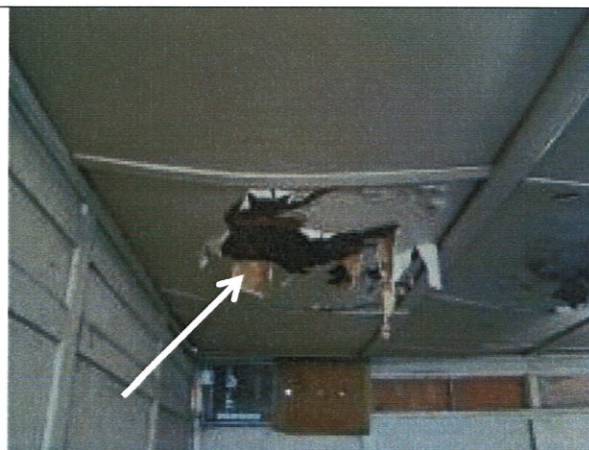
Pav. 8 Vietomis įlinkusios pastato lubos, bet kada gali įlūžti.
