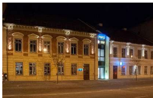
Pav.2.16. Fragmentiškai apšviestas fasadas
