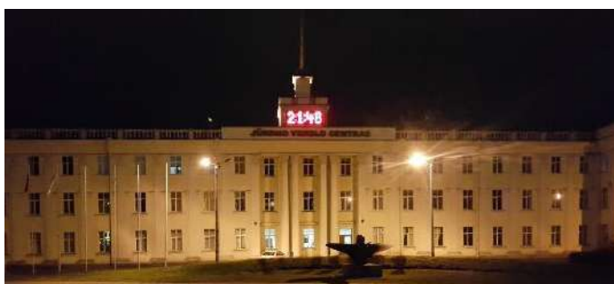
Pav.2.17. Neišraiškingas fasado apšvietimas
