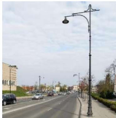
Pav.2.2. Šviestuvai Pilies g.
