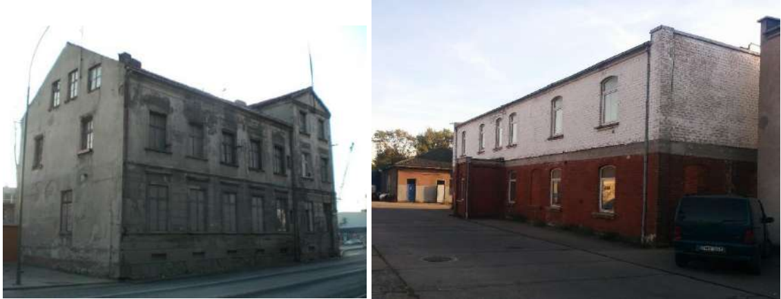
3.28 pav. Vertingujų savybių požymių turintis objektas Naujoji Uosto g. 5 (1) ir teritorijoje esantis kitas objektas Naujoji Uosto g. 3 (2)
