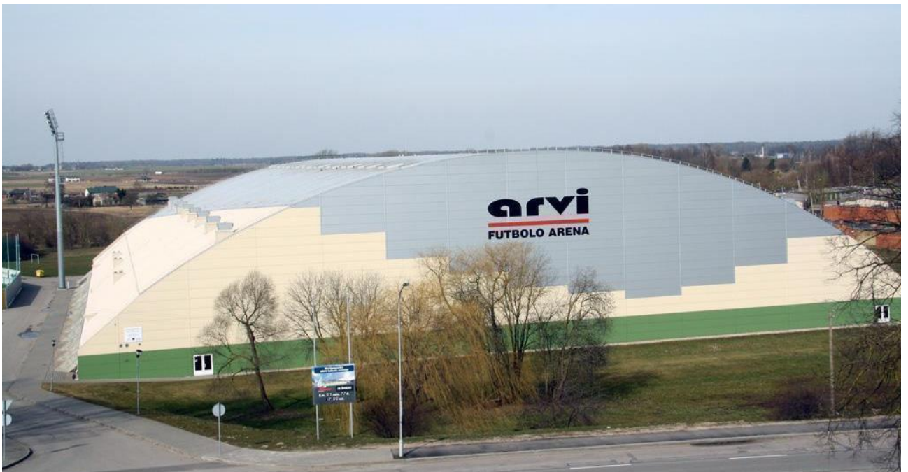
2.3 pav. Marijampolės „Arvi“ futbolo arena (maniežas) (šaltinis: fksuduva.lt)
