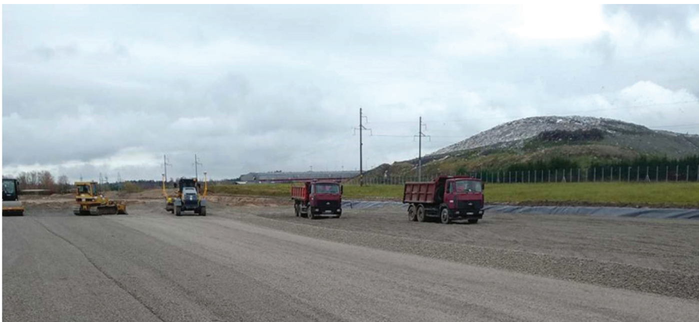
14 pav. Šlako apdorojimo aikštelės (II etapo) įrengimo darbai
