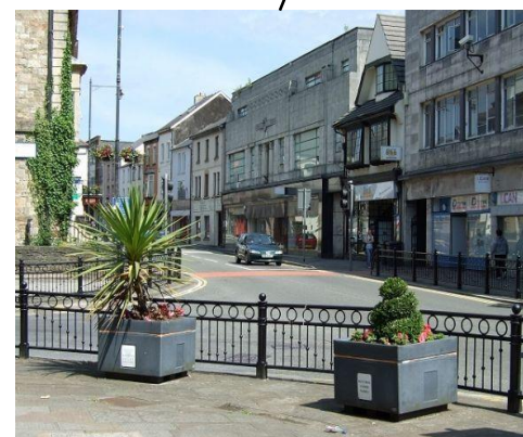
Apsauginė tvorelė nukreipianti pėsčiuosius link perėjos Šaltinis: https://toolkit.irap.org/safer-road-treatments/pedestrian-fencing/
