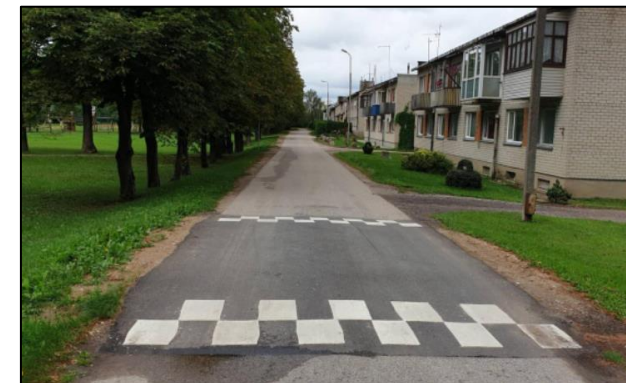
Iškilių greičio mažinimo kalnelio ir horizontaliojo ženklavimo pavyzdys
