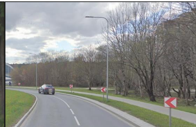
Kelio ženklų segmentų įrengimo pavyzdžiai
