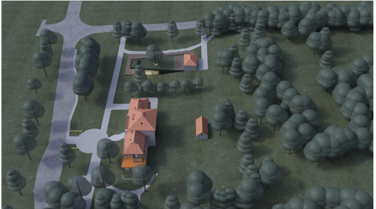
4 pav. Luizės sanatorijos pastatas (viešbutis ir restoranas) ir 2 ūkinis pastatas (kavinė su terasa). Sklypo Nr. 01 A dalis (vaizdas iš pietų pusės)
