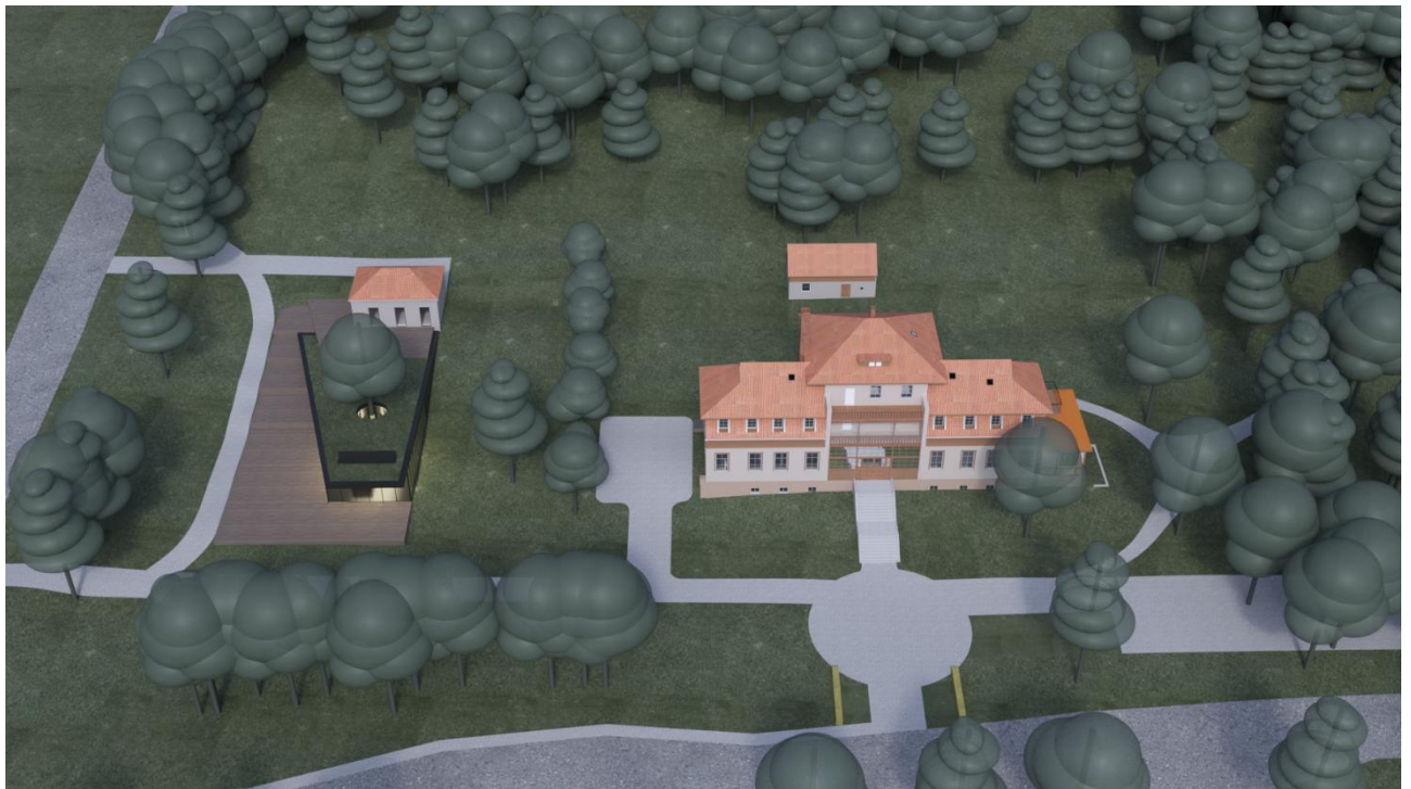
5 pav. Luizės sanatorijos pastatas (viešbutis ir restoranas) ir 2 ūkinis pastatas (kavinė su terasa). Sklypo Nr. 01 A dalis (vaizdas iš vakarų pusės)
