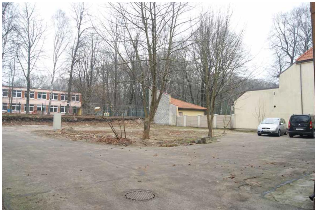
Buvęs gyvenamasis namas Liepų 41 A dėl avarinės būklės 2021 m. buvo nugriautas. Tolumoje vaikų darželio-lopšelio „Svirpliuikas“ pastatytas buvusiam Liepų g. 41 A sklype. Kęstučio Demerecko 2022 m. fotonuotrauka
