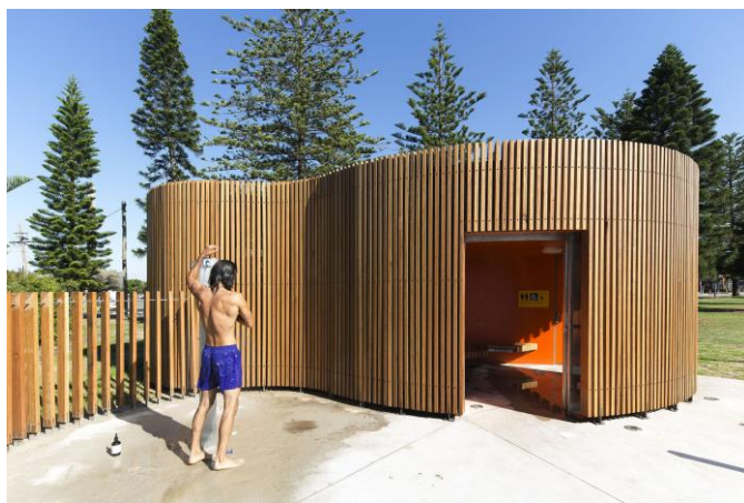
13 pav. Viešojo tualetu su dušu pastatas. Architektas: Fox Johnston. Sans Souci, Sydney, Australia. Nuotraukos: Brett Boardman
