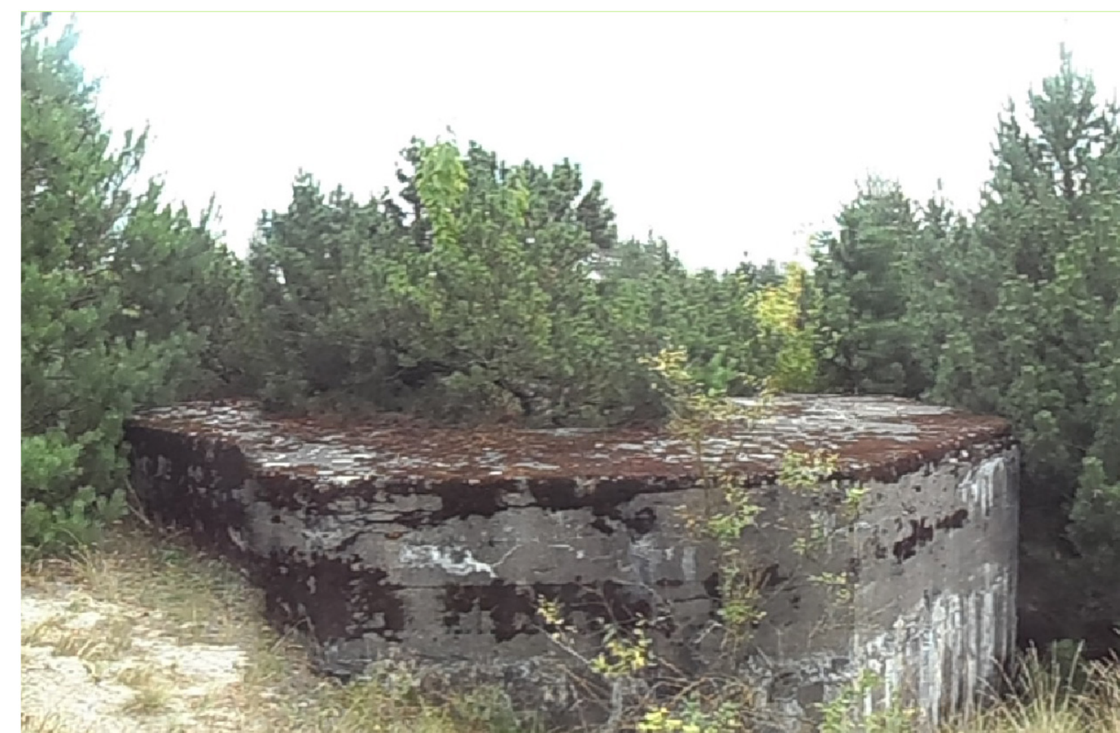
Aštuonkampė betoninė pabūklų platforma
