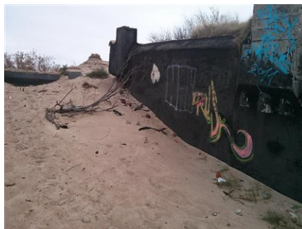
3.02 pav. Melnragės baterijos prieigos (1)
