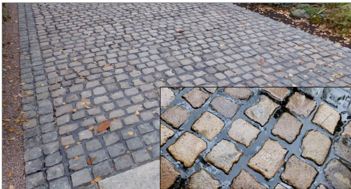
2.5 pav. Akmens dangos užpildymas bitumine mastika
