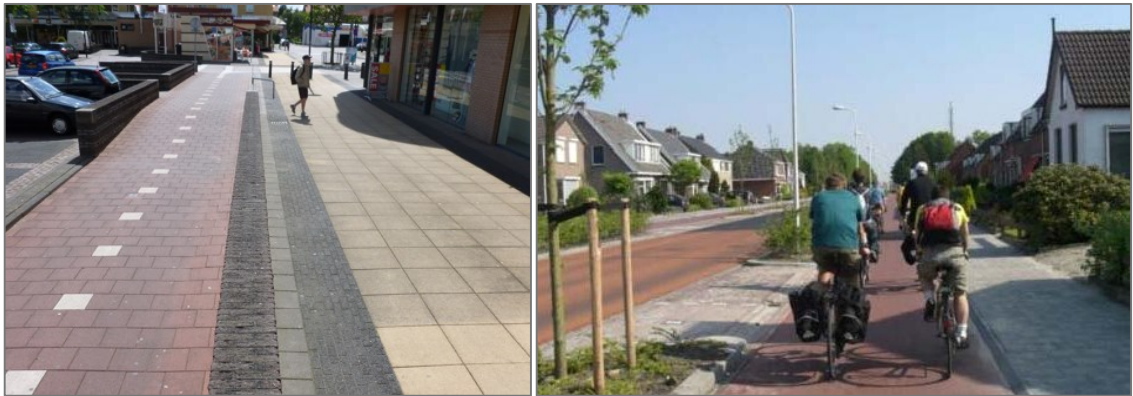
2.2 pav. Dviračių juostų įrengimo pavyzdžiai (kairėje – takas atskirtas juntamos tekstūros juosta, dešinėje – dviračių takas įgilintas pėsčiųjų tako atžvilgiu)
