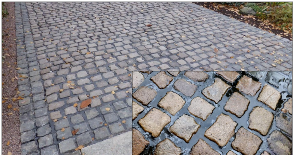
2.5 pav. Akmens dangos užpildymas bitumine mastika
