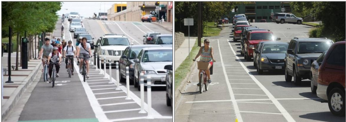
2.3 pav. Dviračių juostų važiuojamoje dalyje įrengimas su saugos priemonėmis
